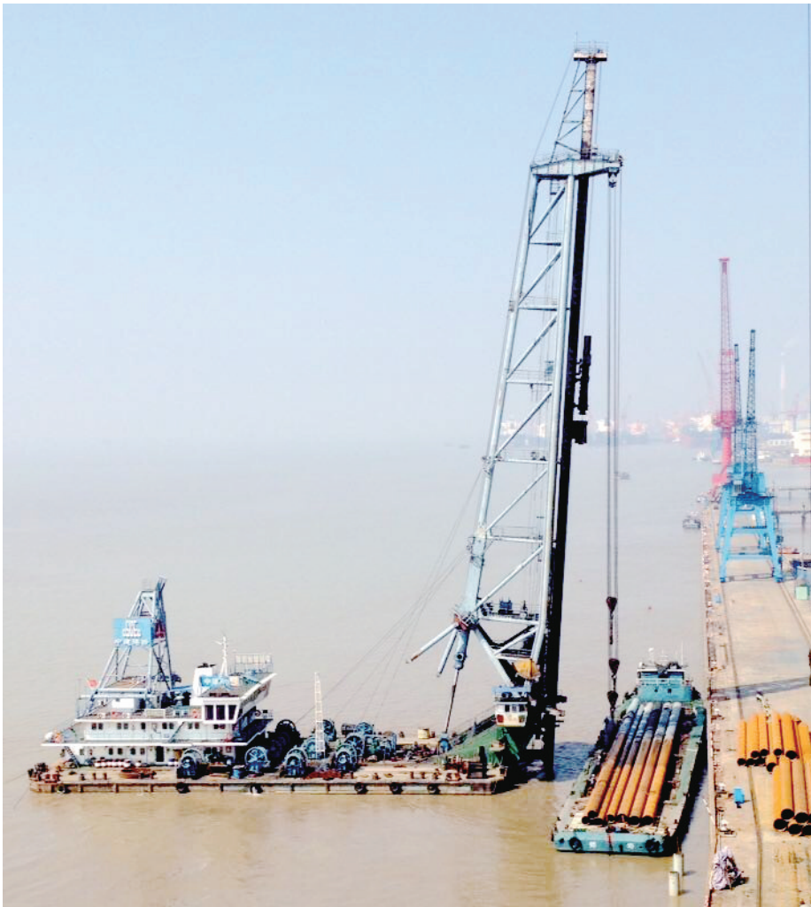
近日,中建港务“桩2号”打桩船用重达12.5吨的铁锤将一根直径0.8米的钢管桩沉至设计标高,标志着中建港务承建的全长920米、位于靖江水域的江苏新世纪码头桩基施工圆满完成。(高晶晶 盛强)
