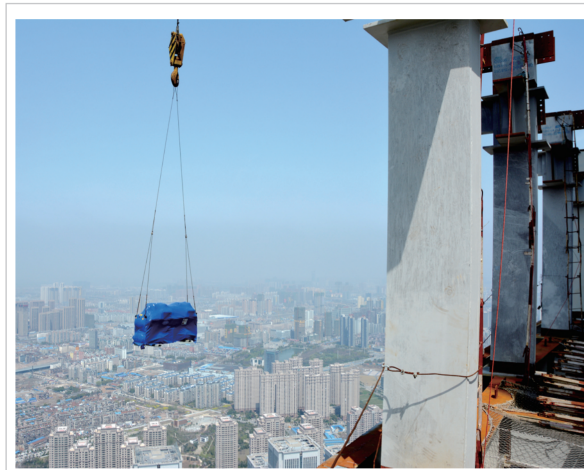
近日,由中建三局总承包、中建一局安装公司负责机电安装的武汉中心项目完成高度达400米的冷水机组吊装,创造了华中地区机电设备吊装高度新纪录。(王天琦)
