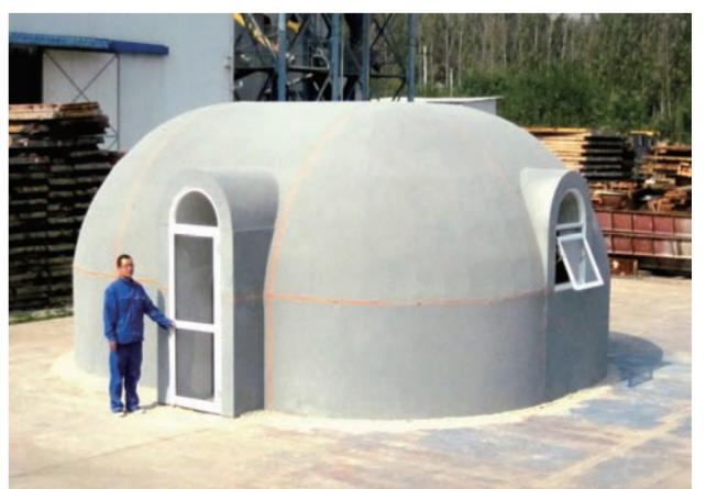
穹顶、圆弧门头，具有中东建筑文化特色的轻质微孔混凝土装配式样板房屋，近日在中建北京李遂中试基地亮相。
