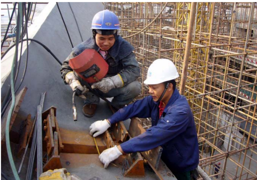
蔡荣根(右)在进行施焊前的焊口复核检查。
