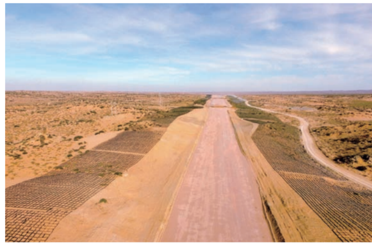
近日,中建六局桥梁公司施工的京新高速公路内蒙古阿盟境内临白段主线防风固沙工程完工,规划中的高速公路两侧共铺设防风固沙方格网760万平方米,施工里程累计49公里。(刘光辉 孔令军)
