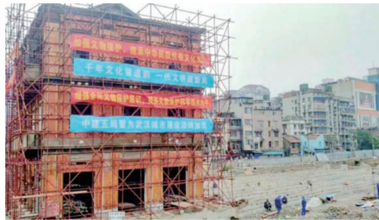
近日,武汉百年老建筑“汉口义勇消防联合会旧址”,经十天平移70米后顺利抵达终点。施工单位中建五局三公司用约1米厚的钢筋混凝土托盘托住大楼,在6个铺有钢板的滑动轨道上,用6个千斤顶顶推完成平移。(肖最高)
