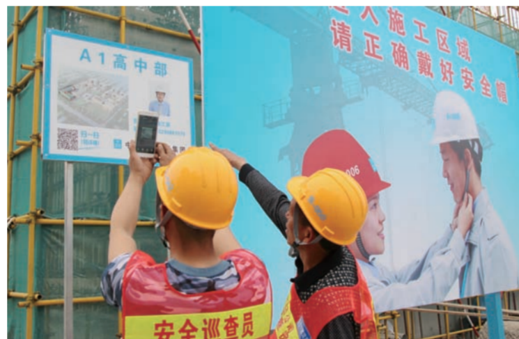
近日,中建一局五公司清华附中凯文国际学校项目积极推进智慧型工地建设,现场采用二维码技术,手机扫一扫信息牌上的二维码,便可掌握该楼建筑结构形式和工程进度信息等。(丁磊)
