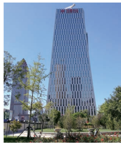
近日,中建一局建设发展公司承建的天津万通项目竣工移交。该项目总建筑面积93556平方米,建筑高度184.4米,是万通地产第一个超深基坑工程、第一个高度超过150米的超高层建筑。(王震宇 赵志强)
