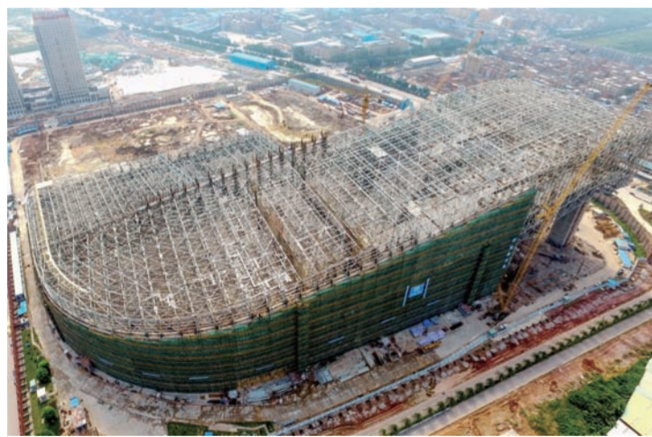
近日,由中建八局总承包、中建钢构负责钢结构一标段制造及安装的全国规模最大、结构最为复杂的广州万达茂室内滑雪场封顶。该工程总用钢量约1.2万吨,建成后可同时容纳3000人滑雪和娱乐。(李鹏 张帅)
