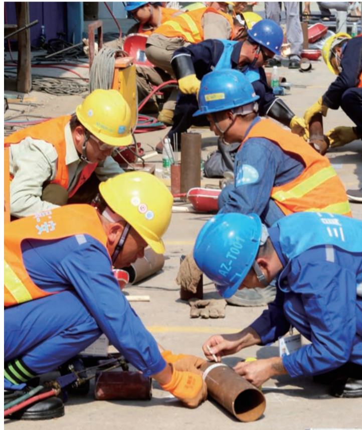
近日,适逢全国第39个“质量月”,中建三局二公司安装公司在世界第三高楼——武汉绿地中心项目举办“寻找身边工匠”机电专业劳动技能比武暨2016年质量月启动仪式。图为管道预制生产线的工人正合作焊接直径100毫米的两段管道,欲与“焊接机器人”试比高。(蔡琴萍 吴继红)
