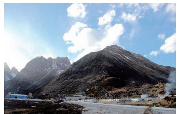
近日,历时4年由中建隧道公司承建的雀儿山隧道顺利贯通。坐落于海拔4377米的川西高原,全长7079米的雀儿山隧道是目前世界海拔最高的超特长公路隧道,也是从川入藏的咽喉要道。(徐志俊)
