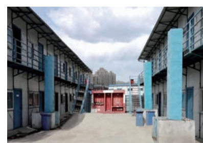
落到一层,既方便二层工人投放,也方便保洁定点清理,营造健康良好的居住空间。
