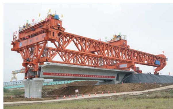
近日,随着重达822吨的箱梁平稳落在中建六局施工的王家湾大桥桥墩上,中国建筑新建汉十铁路孝感至十堰段首榀箱梁成功架设。中建六局铁路公司将负责总共536孔箱梁的预制及架设任务。(尹志强)
