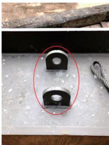
钢构件吊装时原采用的传统吊点——吊耳
