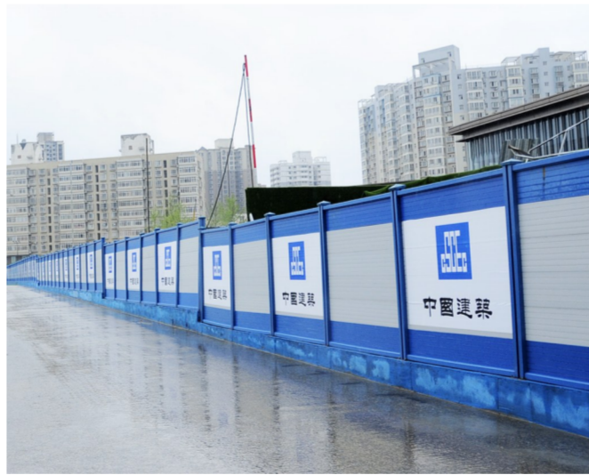
中建二局三公司西安融创项目工地围墙也可“搭积木”
