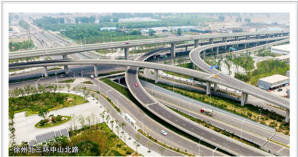
同一个团队，同一个工程，获得两项鲁班奖，这不是运气，这是中建七局二公司坚持品质发展、持续提升的结果，更是该公司坚持“专注市场、专注现场、专注成长”的结果。
