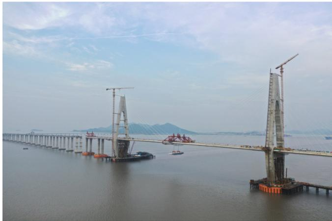
平潮期进行船舶作业，项目部科学规划，精准捕捉施工时机，顺利实现吊机安装，为钢箱梁的大规模施工铺平道路。据项目经理曹海清介绍，此次南通航孔桥合龙时梁段使用340吨吊距可调整一体式桥面吊机单侧吊装，并采用配重辅助温度配切合龙技术，即在合龙段吊入前，合龙口两端无劲性骨架连接，处于自由状态。该技术充分考虑了温度影响，实现了大桥的毫米级合龙。
