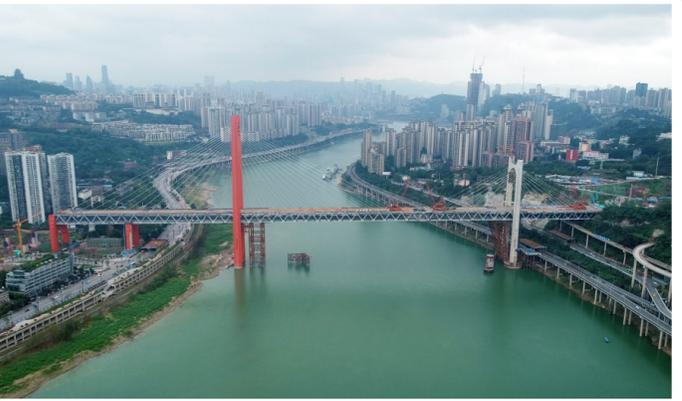
11月24日,由中建桥梁承建的重庆首座公轨两用高塔斜拉桥——重庆红岩村嘉陵江大桥实现“零误差”精准合龙,为实现全线贯通奠定坚实基础。 (曾 艳)
