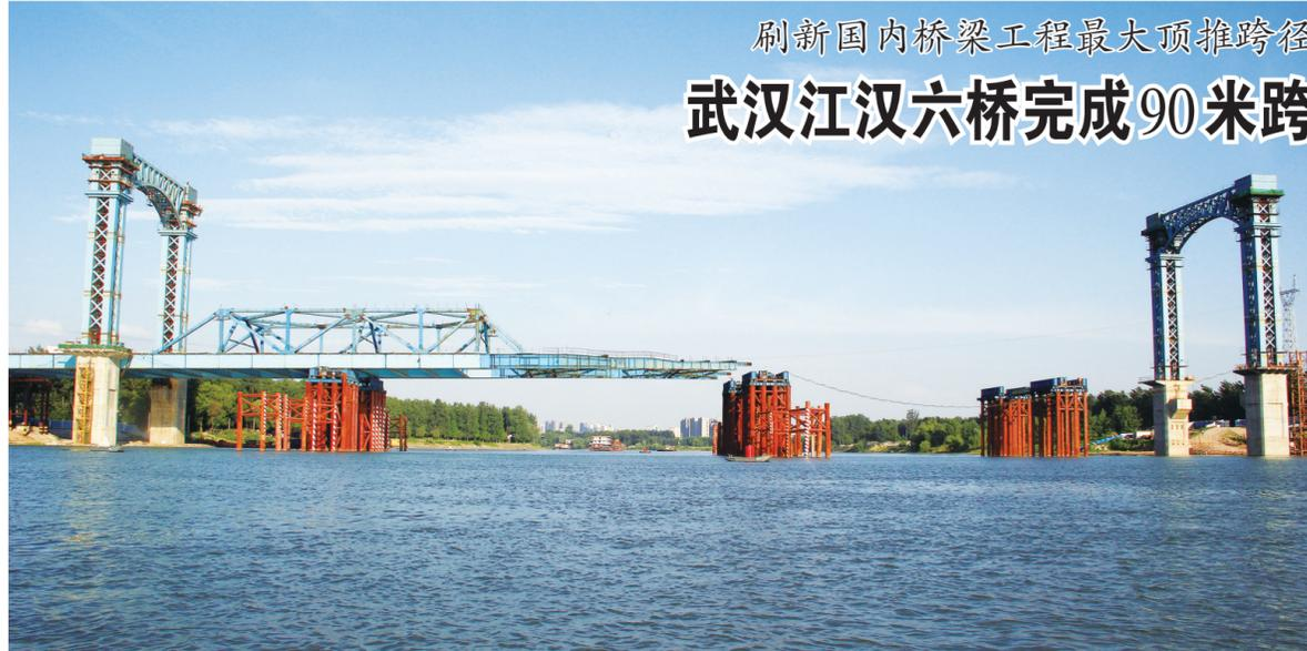
本报讯(通讯员崔伟 谭神洲)6月17日19:00,武汉江汉六桥完成了主桥钢梁第六次顶推施工,主桥导梁前端在悬空跨越90米跨径的1#和2#江中临时墩后成功接轨,本次顶推最大跨径90米,顶推重量达2600吨,一举刷新了国内桥梁工程最大顶推跨径的施工纪录。
