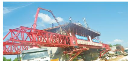
近日，经过七个多小时的连续浇筑，中建土木铁路分公司吉图珲客专专线(起点于吉林市，终点位于地处中、俄、朝三国交界的珲春市)项目永强特大桥首根移动模架现浇箱梁浇筑完成。
