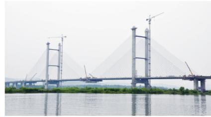
近日，由中建三局总承包公司承建的襄阳汉江三桥主梁悬臂浇筑施工结束，104对斜拉索全部安装并张拉完毕，优美的桥型跃然呈现。
