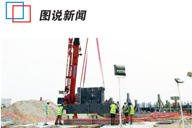
8月3日,中建钢构顺利完成阿布扎比国际机场项目的首段吊装,该机场形似巨型英文字母“X”,总建筑面积约55万平米,钢结构总用量约6万吨。(李青)
