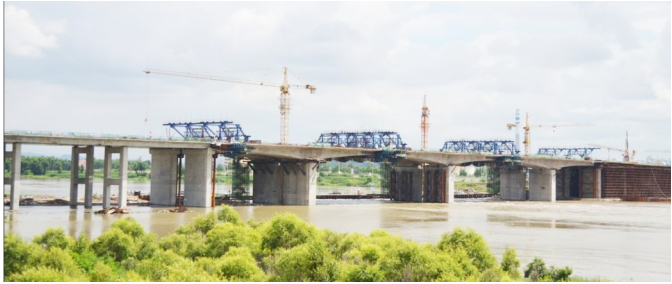
近日,中建六局承建的松花江上又一座大桥——吉林秀水大桥完成主体结构施工,顺利实现合龙。该桥全长828米,宽29.5米,建成后将实现珲春北街与秀水街贯通,成为连接吉林化工园区与市中心的重要交通枢纽。(刘磊 梁爽)
