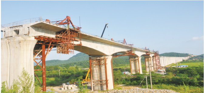
日前,中建二局土木公司沈丹客运专线大沙河连续梁最后一段合龙,这是中国建筑股份承建的沈丹客专TJ-3标段11座连续梁中唯一一座既有铁路线又有公路线的“双跨”连续梁。(韩展)
