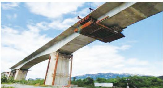
近日,由中建交通沈丹客专四工区承担施工的大沙河特大桥最后一个墩身浇筑完毕。大沙河特大桥全长1715米,该连续梁为跨越有沈丹铁路和老丹汤公路的难点工程。(黄启钊)
