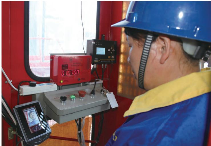
“这部电梯只认我一个人,比认亲生儿子还准!”电梯操作工胡少先乐呵呵地说。近日,在中建三局总承包公司武汉花楼街项目13部投入使用的施工电梯,全部安装了这种“人脸识别”系统,该类电梯还具有防超载和防冲顶功能。通过技术手段,电梯超载或与顶部接近危险距离时,将报警并停止运行。(程超 覃华雄/摄影报道)
