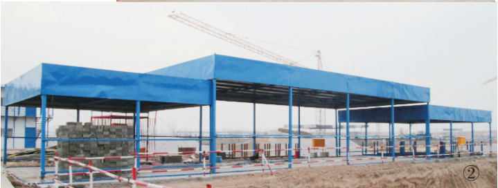
图②：推拉棚左右滑动展开
