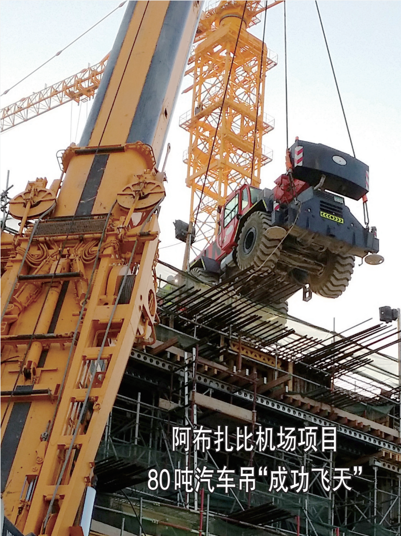
阿布扎比机场项目80吨汽车吊“成功飞天” 近日,中建中东和中建钢构联合承建的阿布扎比国际机场项目,完成目前该项目最大一次吊装作业,将80吨汽车吊由0层筏板平稳吊至高差16米的二层楼面。 (曾志文/摄影报道)
