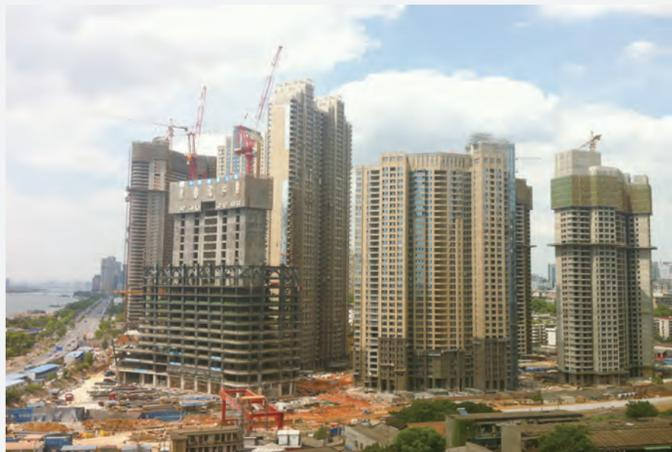
4月11日,由中建五局三公司承建的长沙保利国际广场超高层项目B3栋核心筒剪力墙钢筋绑扎达到46层,开始进入200米以上结构施工。此项目是湖南省首座设有伸臂桁架结构、首个运用爬模施工技术的混合框架超高层建筑。(白忠奎 章燕青/摄影报道)
