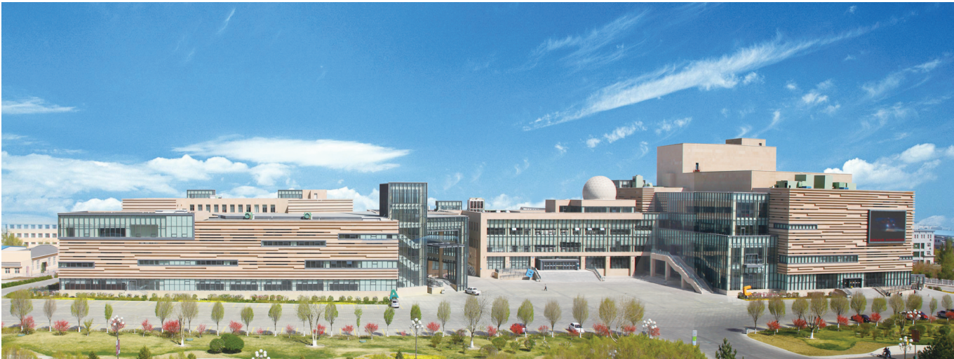
中建新疆建工四建承建的新疆克拉玛依独山子区文化中心工程,建筑外立面巧妙运用现代石材和钢骨架支撑体系,完美展示出新疆独特的“雅丹风蚀地貌”,使公共建筑具有特有的文化内涵,属全国首例。(王文娟 那银光/摄影报道)
