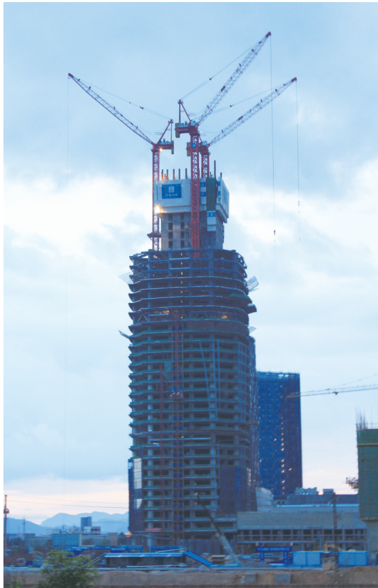
近日,中建四局安装公司武汉分公司云南事业部昆明西山万达广场项目部经过10小时奋战,顺利完成难度较大的南塔22层设备吊装任务,展示了该公司实施高层吊装的实力。(姚峰/摄影报道)
