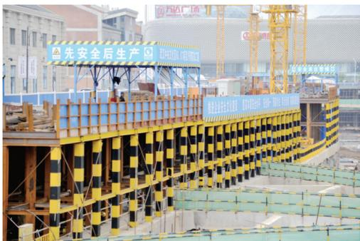
近日,中建二局三公司武汉万达中央文化区K6K7项目投入近千万元,开辟出长近200米、总面积约5000平方米的人工钢平台“栈道”用于钢筋、扣件、模板等材料的码放和加工。如此大规模在基坑边坡设人工“栈道”作为材料码放区在湖北省尚属首家。(闻江 张爱民/摄影报道)
