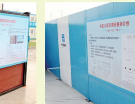
中建八局现场展示了采用钢管和钢板组合,通过螺栓连接的外围挡。其强度高,安装快捷,可周转使用,可100%回收利用。
