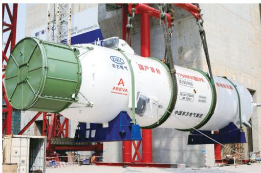
近日,中建电力台山核电核岛项目使用马蒙特装置及核反应堆厂房大吊,成功引入首台国产175万千瓦级EPR核电稳压器。(杨梓楠 廖伟成/摄影报道)
