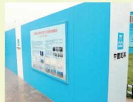
中建七局在本次现场推进会上展示的外围挡,由PVC材料制作,轻便结实耐老化,拼装速度快。值得一提的是,由于工厂化制作时,可在材料中添加“中建蓝”颜料,因此成品可直接体现中建CI要求,无需另外涂刷。
