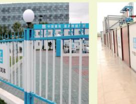
中建四局本次推进会上展示了一款利用热塑性材料和木粉等辅助材料挤压制作的外围挡,材质耐候性好,免维护,还可100%回收并循环使用。该围挡安装便利,4名工人每天可安装100米。
