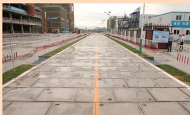
走入中建八局北京中国移动项目临建设施标准化推进会现场,首先吸引与会代表注意的是一条干净整洁,由一块块钢框混凝土模块拼接的路面。模块周边是钢框,表面两个孔内,隐藏着用来吊装的挂钩。
