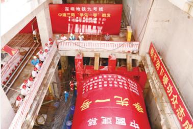
近日,中建三局投资建造、刀盘直径6米的首台盾构机“争先一号”在深圳地铁9号线9104-1标段始发,开始在向西村站至文锦站区间施工。(杨登科 韩成林/摄影报道)
