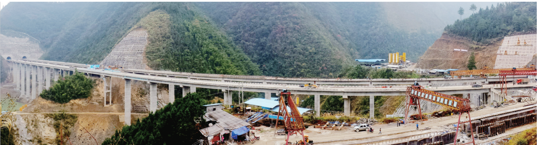
近日,由中建五局承建的湖南省“五纵七横”高速公路网中的第三横——新化至溆浦高速公路西段十标段隧道、桥梁全部实现贯通。该标段由3座总长1648米的大桥和全长4333米、横穿雪峰山的隧道组成。
