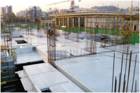
近日,中建五局中建信和城项目部在8#栋施工中采用铝模工艺,进度快、质量好,现场实测结果完全符合规范要求。(唐中辉 张妍)
