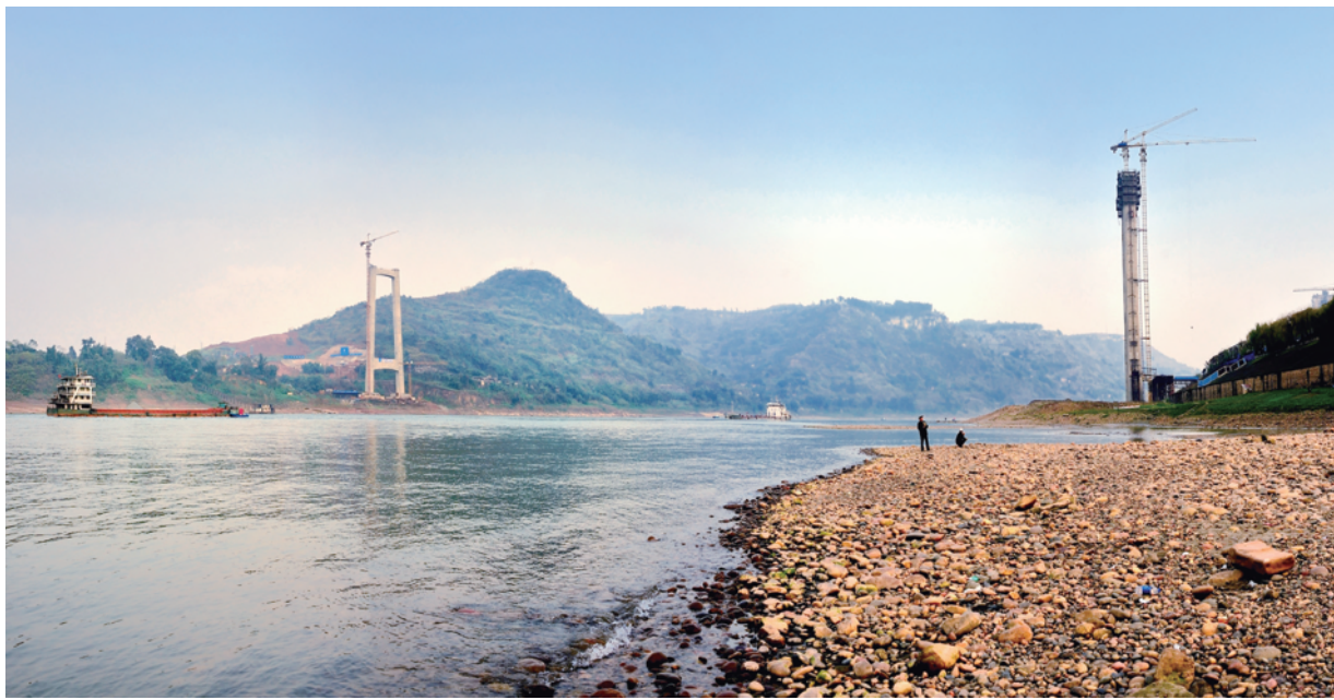
近日,中建六局承建的重庆几江长江大桥悬索桥南、北主塔全部实现封顶。大桥南塔高约112米,北塔高约106米,可抵御5000吨级单船撞击。(赵蘅生)
