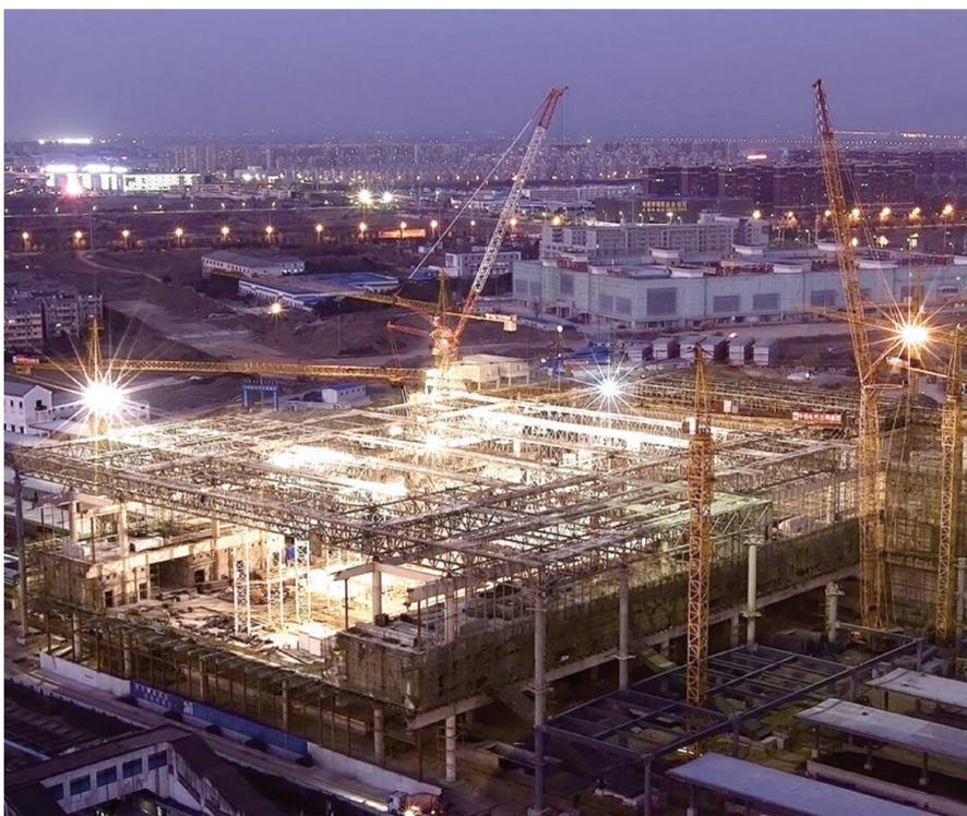
日前,中建钢构承建主体结构工程的芜湖火车站封顶。该站是国内最大的地市级火车站,车站设计有3个站场和8个站台,建筑面积达49988平方米,主体结构采用“钢管混凝土框架+空间管桁架屋盖”的结构形式,最大跨度为165米,一榀桁架就重达45吨。(刘克扬)
