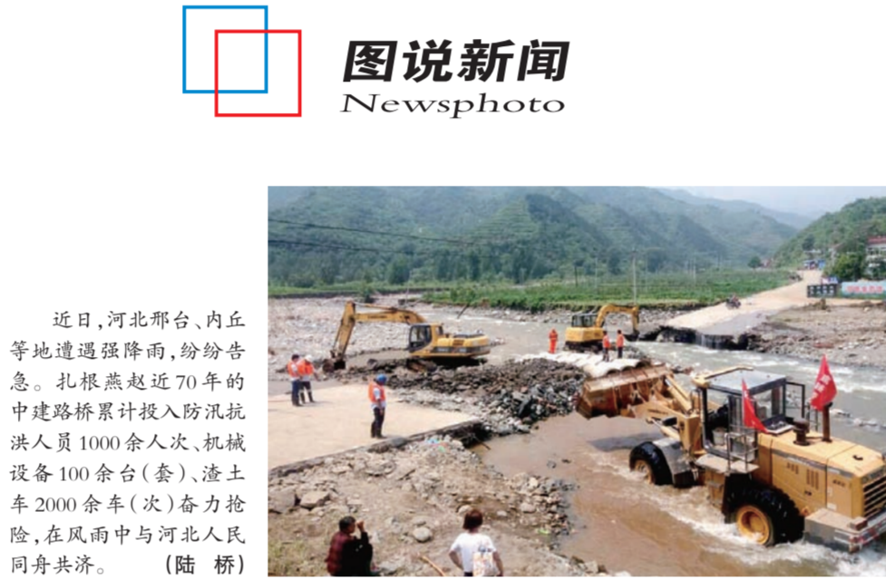
近日,河北邢台、内丘等地遭遇强降雨,纷纷告急。扎根燕赵近70年的中建路桥累计投入防汛抗洪人员1000余人次、机械设备100余台(套)、渣土车2000余车(次)奋力抢险,在风雨中与河北人民同舟共济。(陆桥)
