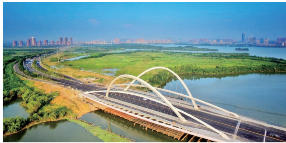
近日,随着武汉泥江湖大桥的通车,由中建三局一公司承建的武汉东西湖金银湖环湖路改造工程全线贯通。该工程全长9.42公里,由5座造型各异的桥梁串联而成。图为结构复杂、造型优美的扁型蝴蝶拱桥。(程超 周俊)
