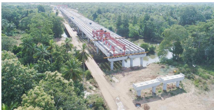
斯里兰卡南部高速延长线第三标段项目瓦拉维河桥T梁架设完工
