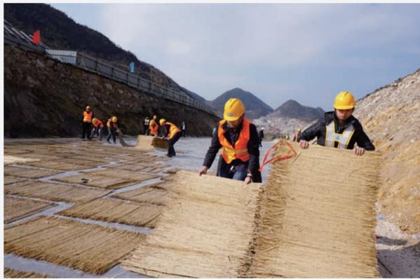
近日,中建二局西南分公司六盘水市地下综合管廊项目部抓住难得好天气,组织人力揭开管廊混凝土上覆盖的保温草席,散湿增温,为下一步防水施工做准备。(陈柯宇 陈博)
