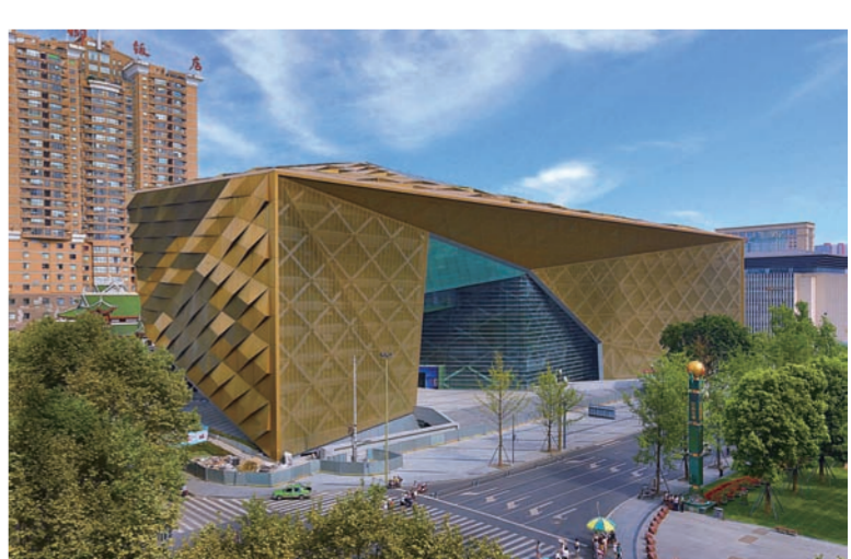
近日,由中建二局西南分公司承建、总建筑面积6.5万平方米的中国西南地区最大城市博物馆——成都博物馆新馆通过竣工验收。该馆同时也是目前世界上皮影藏品数量最多的皮影专题博物馆。(赵长海 张超)
