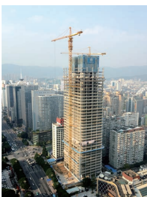
近日,中建海峡施工的海西商务大厦项目核心筒封顶。该项目位于福州市CBD中心,总建筑高度173.95米,建成后将成为国际化5A级智能型高端商务大楼。(张乾)
