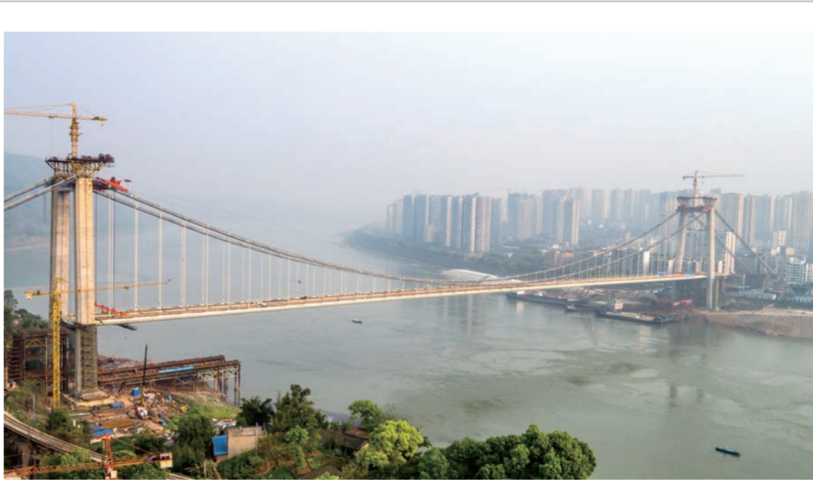
近日,中建六局承建的重庆江津几江长江大桥累计55段、总重11147.19吨的主桥钢箱梁合龙。几江长江大桥是一座地锚式悬索桥,主跨600米。(段超 姜蒙 吴刚)
