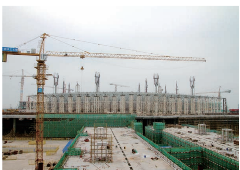
近日,中建钢构有限公司承接钢结构施工的港珠澳大桥珠海口岸旅检大楼钢结构工程网架提升就位。此次提升网架面积达2.6万平方米、重量达4000吨。(彭庆南 胡瀚南)
