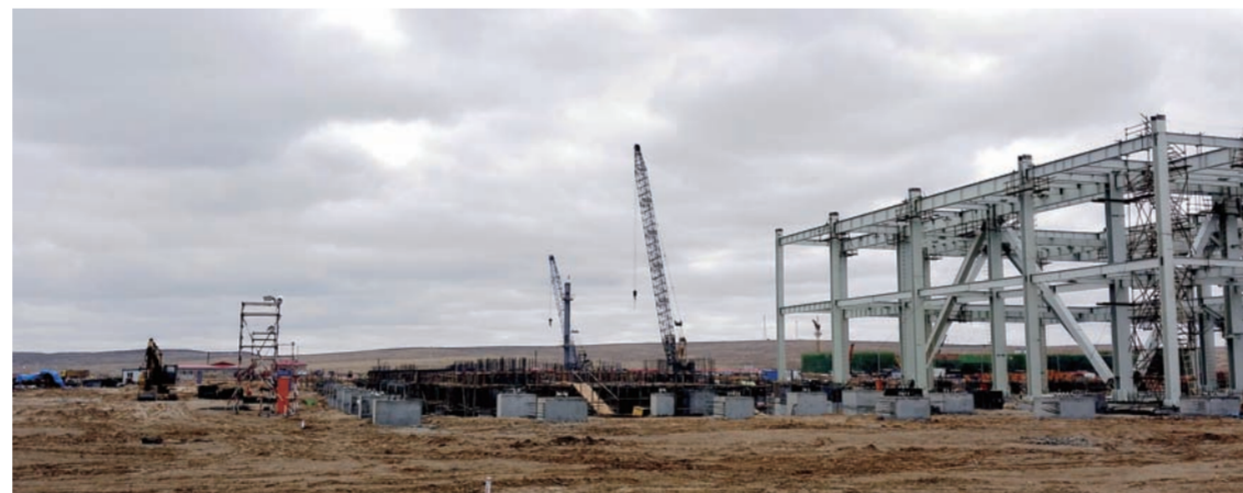
近日,中建钢构北方大区在基础设施领域承接的第一个电厂项目——华润电力五间房电厂项目顺利开吊。该项目位于内蒙古自治区锡林郭勒盟境内,是华润电力内蒙古煤、电、路、港一体化项目一期建设重点工程,预计10月竣工。(胡公成 张海波)
