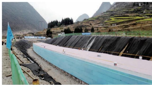
近日,中建二局三公司施工的地下综合管廊试点城市——六盘水PPP项目钟山区凤凰大道东段第一阶段主体结构全部完工。据悉,该段管廊宽4.85米、高3.65米,全长2.7公里,顶板覆土2米。管廊分综合仓和燃气仓,分别入廊给水、通信、10KV电力、110KV电力和燃气等管线。(宋龙跃 闻江)
