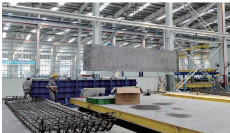
近日,随着一段长约6米、宽1.28米,共17踏的预制楼梯成功脱模,中建科技PC构件厂正式进入规模生产阶段。据悉,此次生产的预制楼梯共612块,主要用于公司福州东江欣居项目。(李小燕)
