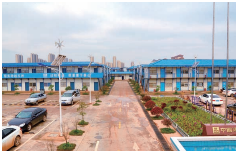
近日,中建二局三公司南昌片区四个项目配备了近百台风电太阳能灯,可同时使用风能和太阳能两种清洁能源供电,用于办公区、生活区和现场道路夜间照明。(施振源 郭钟阳)
