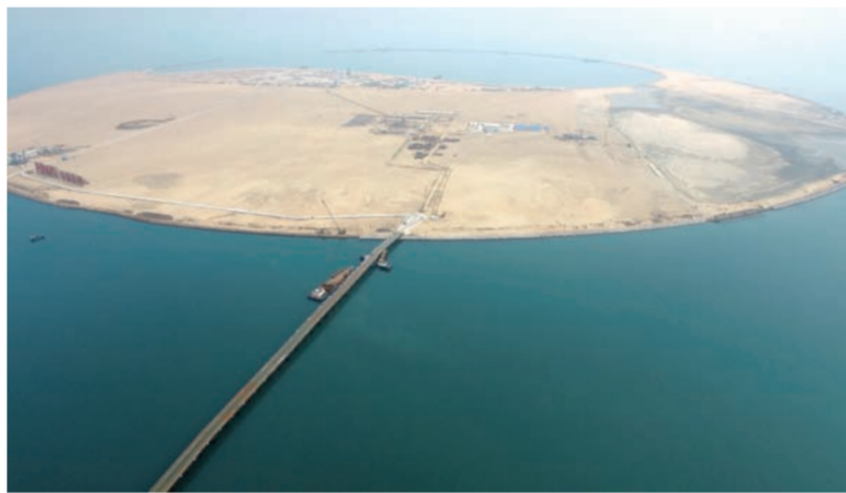
近日,中建六局华东公司承建的海口市南海明珠大桥项目、全长2033米的钢栈桥合龙。该钢栈桥桥面标高6.3米,主桥段栈桥宽12米,可承受100吨荷载,建成后将成为南海明珠人工岛和海口市区的陆上通道。(王宇飞)
