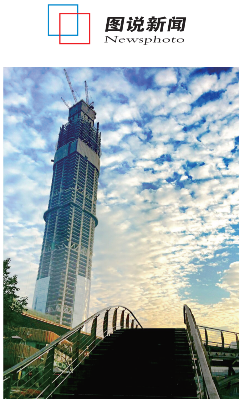
近日,中建三局三公司苏州国金项目中心项目核心筒封顶,结构高度达到421米,成为江苏第一高楼。该项目是江苏地区软土地基上建造的首个65万吨级单体建筑。项目用钢量约70000吨,钢结构部分施工由中建钢构实施。(丁 韬)
