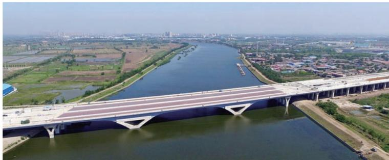
近日,中建六局承建的天津蓟汕高速公路全线重点控制性工程——海河特大桥主体工程贯通。大桥全长1210米,主桥中跨110米,为天津市跨海河桥梁最长跨径。目前,项目工作人员正在进行收尾施工,为8月份全线通车运营做好准备。(张海旺 周伟)
