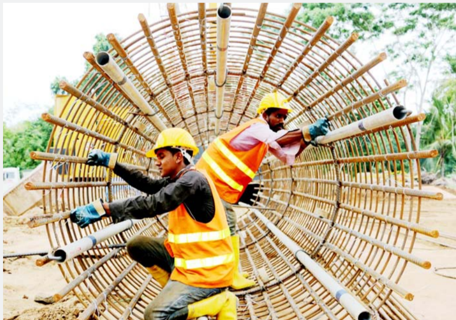
中建三局基础设施公司承建的斯里兰卡南部高速工程瓦拉维河大桥水加冰拌合浇筑
