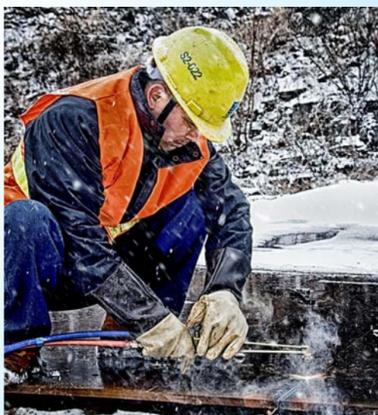
近日,天降大雪,中建三局北京公司石家庄平赞高速(平山至赞皇)04标段坚持冒雪施工,因为工人在-13℃的低温下冒雪对隧道支护所需的钢结构护架进行焊接。(陈梦钊)
