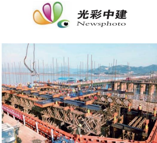
中建七局交通公司 台州浦坝港特大桥梁18号主墩吊箱围堰开始下放
