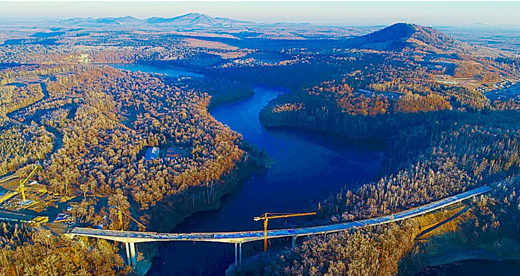
中建八局东北公司承建的吉林漫江胜地桥提前161天竣工通车
