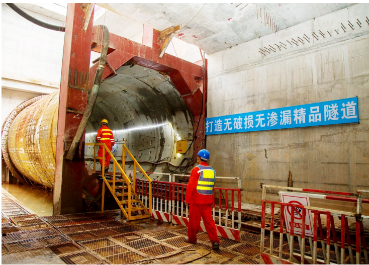
中国建筑深圳地铁9号线西延线项目“践行深圳质量、打造无破损、无渗漏隧道”主题系列活动
