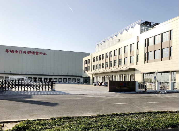
中建七局承建的中国内陆最先进自动化冷库落成
