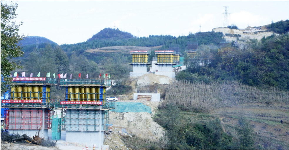
正在施工中的黄泥洞特大桥
