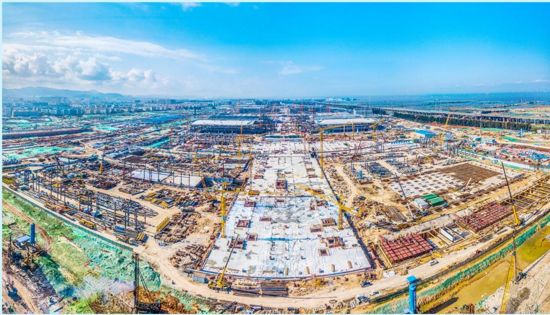
近日,中建股份承建的深圳国际会展中心(一期)项目地下室结构封顶。该项目地下室面积达57万平方米,最大长度达1700米,是全球房屋建筑领域面积最大、长度最长的无缝钢筋混凝土结构地下室。
