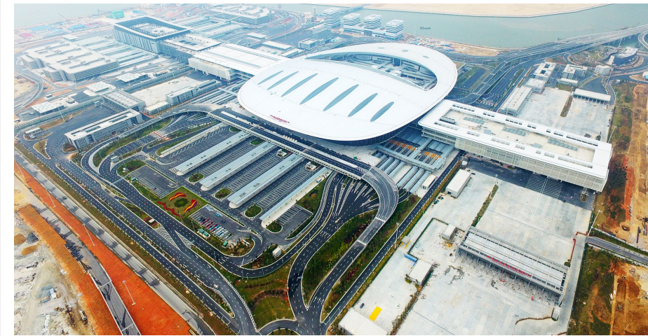
中国建筑承建的港珠澳大桥珠海公路口岸工程
