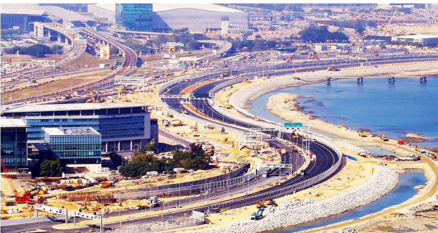
中国建筑承建的港珠澳大桥香港接线工程
