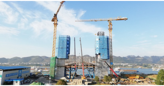
伍家岗长江大桥塔桥平台顶升现场
