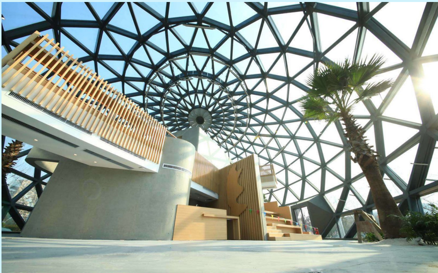
近日，中建钢构承建的江苏省靖江市容湖书吧投入使用。该书吧为球形装配式钢结构建筑，从内部抬眼望去像一个倒扣的鸟窝，被当地人称为“小鸟巢”，是一座集阅读、观景、休憩等功能于一体的临水景观建筑，藏书2万册，营造了全民阅读的良好氛围。（吴青云）
