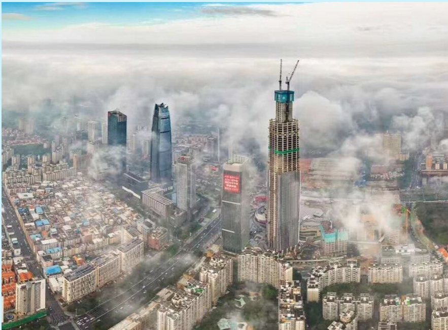
近日，中建五局广东公司承建的东莞国贸中心项目T2塔楼核心筒提前实现主体结构封顶。该项目是东莞地区规模最大、定位最高的商业综合体，总建筑面积104万平方米，其中T2塔楼为东莞市最高建筑物，总高度达428.8米。（洪海坚、巫业通）
