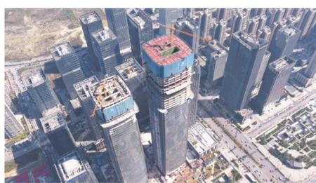
3月20日,随着第66层梁板最后一方混凝土浇筑完成,中建四局六公司贵州分公司承建的贵州省在建第一高楼——贵阳国际金融中心双子塔1号主楼高度突破300米。贵阳国际金融中心双子塔位于贵阳市金阳新区,1、2号楼高度分别为401米、275米。1号主楼为目前国内最高的全钢筋混凝土楼盖结构超高层建筑。(刘启)
