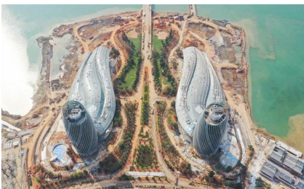
近日,中建三局总承包公司承建、中建钢构负责钢结构制造安装的海南儋州恒大海花岛希尔顿双塔酒店项目钢结构完工。该工程由双塔建筑及交通枢纽组成,总建筑面积10万平方米,双塔高度分别为104.66米、103.94米,在入岛口交相辉映,线条的扭转变化趋势与枢纽屋顶巧妙结合,创造出流动美。(何小伟、李容芳)
