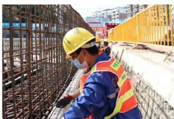
近日,中建福州地铁4号线2标项目正式复工,项目员工在严格做好疫情防护前提下积极投入工作。图为木工正在进行小里程端头冠梁模板安装。(曾辉)
