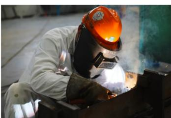
近日,中建电力广东太平岭核电项目钢衬里及1号核岛养护恢复施工,项目员工在严格做好防护的前提下开展工作。图为焊工正在进行钢衬里焊接操作。(候威亮)
