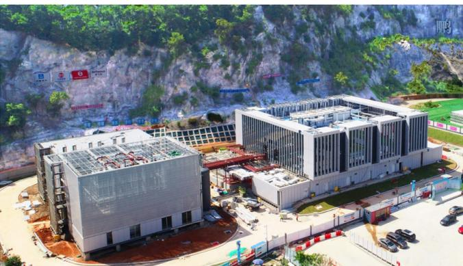
测量，这一天，测量员们扛着仪器，足足走了5万多步……正是基于“地基”的精细打造，110个箱体得以一次吊装完成。
