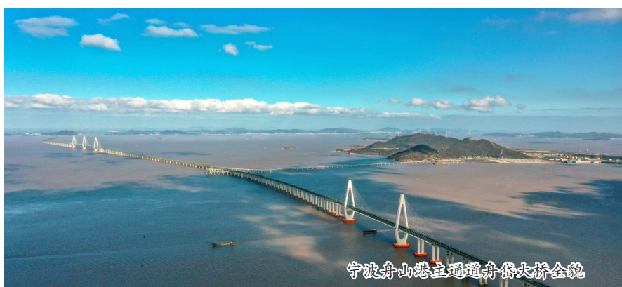
互通匝道长4.169公里，合计9.514公里。施工区域共分为南通航孔桥、南非通航孔桥、长白互通三大海上施工区域。
