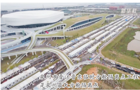
泉州市晋江晋东临时方舱隔离点工程是泉州最大方舱隔离点
