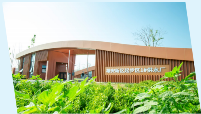
雄安新区起步区1号供水厂（净水厂）
