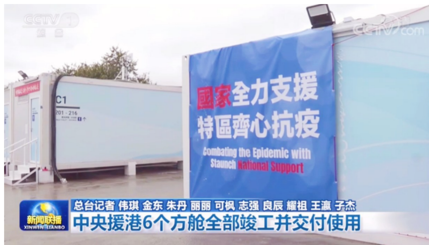
总台记者 伟琪 金丹 朱丹 丽丽 枫枫 志强 辰辰 耀祖 王滢 子杰 中央援港6个方舱全部竣工并交付使用
