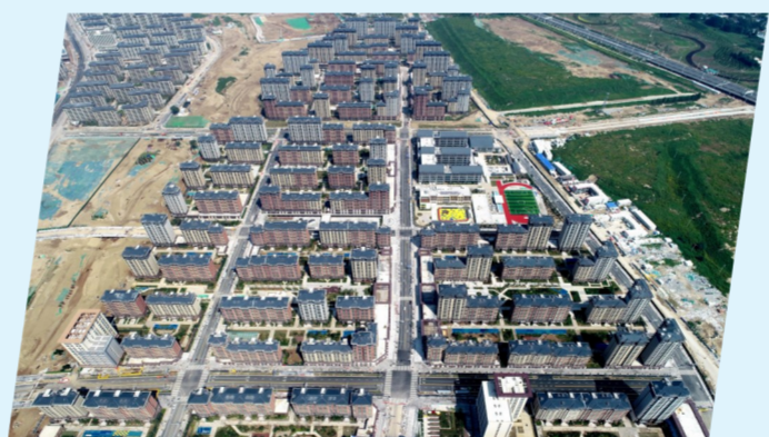
雄安容东片区G组团安置房
