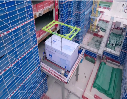
△2025年12月，深圳市人民医院宝安医院感染楼首个嵌入式模块顺利完成吊装及平移。
