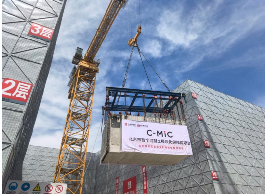
△6月26日，北京海淀区定慧寺北地块保租房项目智能建造-MiC技术吊装现场。
