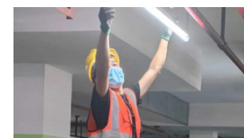
加裝流量裝置
