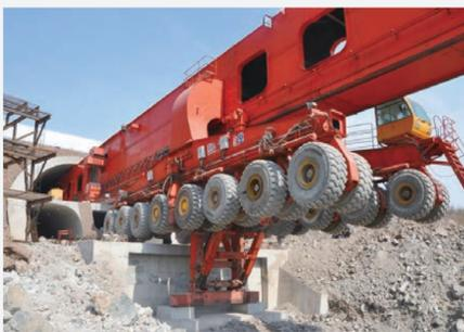
近日,在机器轰鸣的欢腾气氛中,中建土木公司吉图珲项目采用运架一体机成功完成了首榀箱梁架梁任务,为项目后续31孔箱梁的架梁创造了良好的开端。(张甲云 黄克所/摄影报道)
