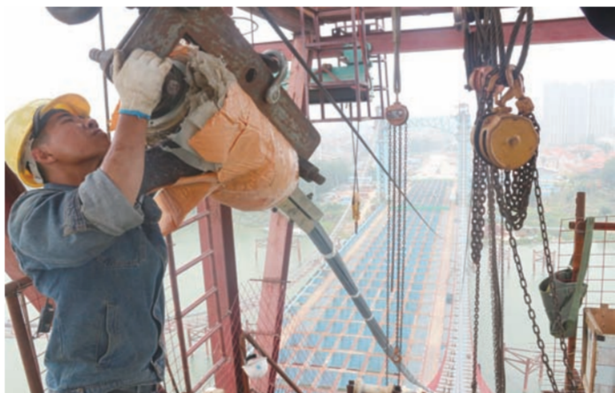
近日,随着工人将最后一根索股成功牵引过江并入鞍,中建三局总承包公司承建的武汉江汉六桥左右两个主缆全部架设完成。该自锚式悬索桥的2根主缆分别由37根索股组成,最长索股长达11.7吨。(易娟/摄影报道)
